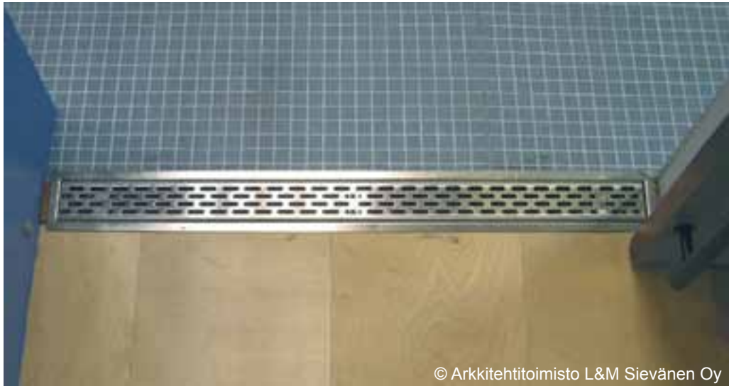
Kuva 25. Kynnyskaivo kylpyhuoneen oviaukossa.
