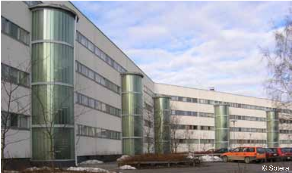
Kuva 11. Jälkiasennushissi voidaan asentaa myös rakennusrungon ulkopuolelle.
